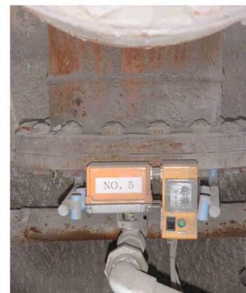
大口径配管のエルボ部のドレン抜きに使用
